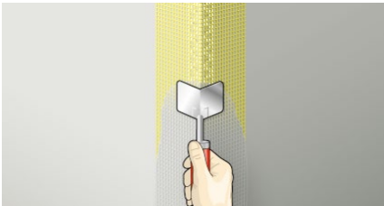
18 pav. Išorinio sienos kampo sutvirtinimas kampiniu profiliu.
